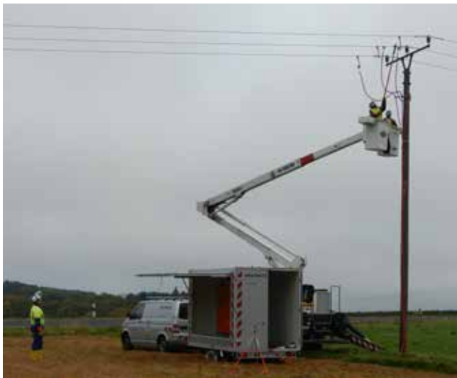
Anwendung eines Arbeiten-unter-Spannung-Verfahrens (AuS) zur Vorbereitung einer Erdschlussmessung an einem 20.000V Holzeinfachmast
